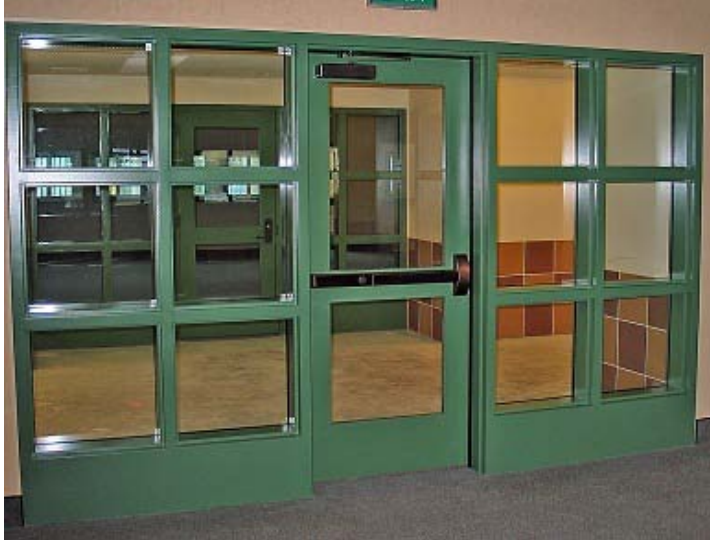
45 min. door with 45 min. sidelites
