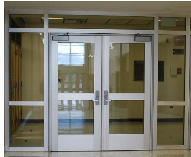
90 min. door with 120 min. sidelites/transoms
