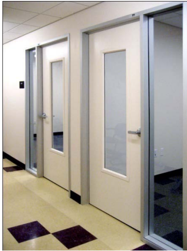
20 min. door with 45 min. sidelites
